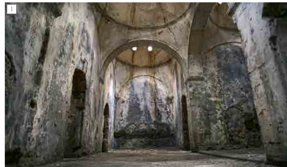
Άποψη από το εσωτερικό του χαμάμ στη συμβολή των οδών Ζαμπελίου και Δούκα. Πόλη Χανίων. Εφορεία Αρχαιοτήτων Χανίων
